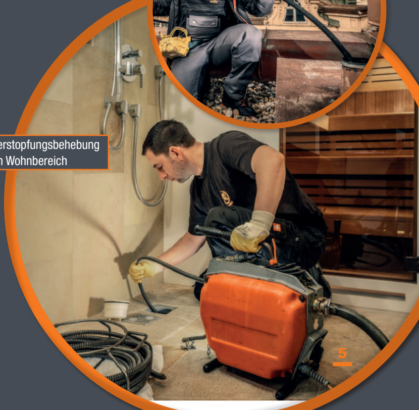
Fallstrangreinigung über Dachentlüftungen
