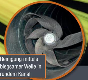
Reinigung mittels biegsamer Welle in rundem Kanal
