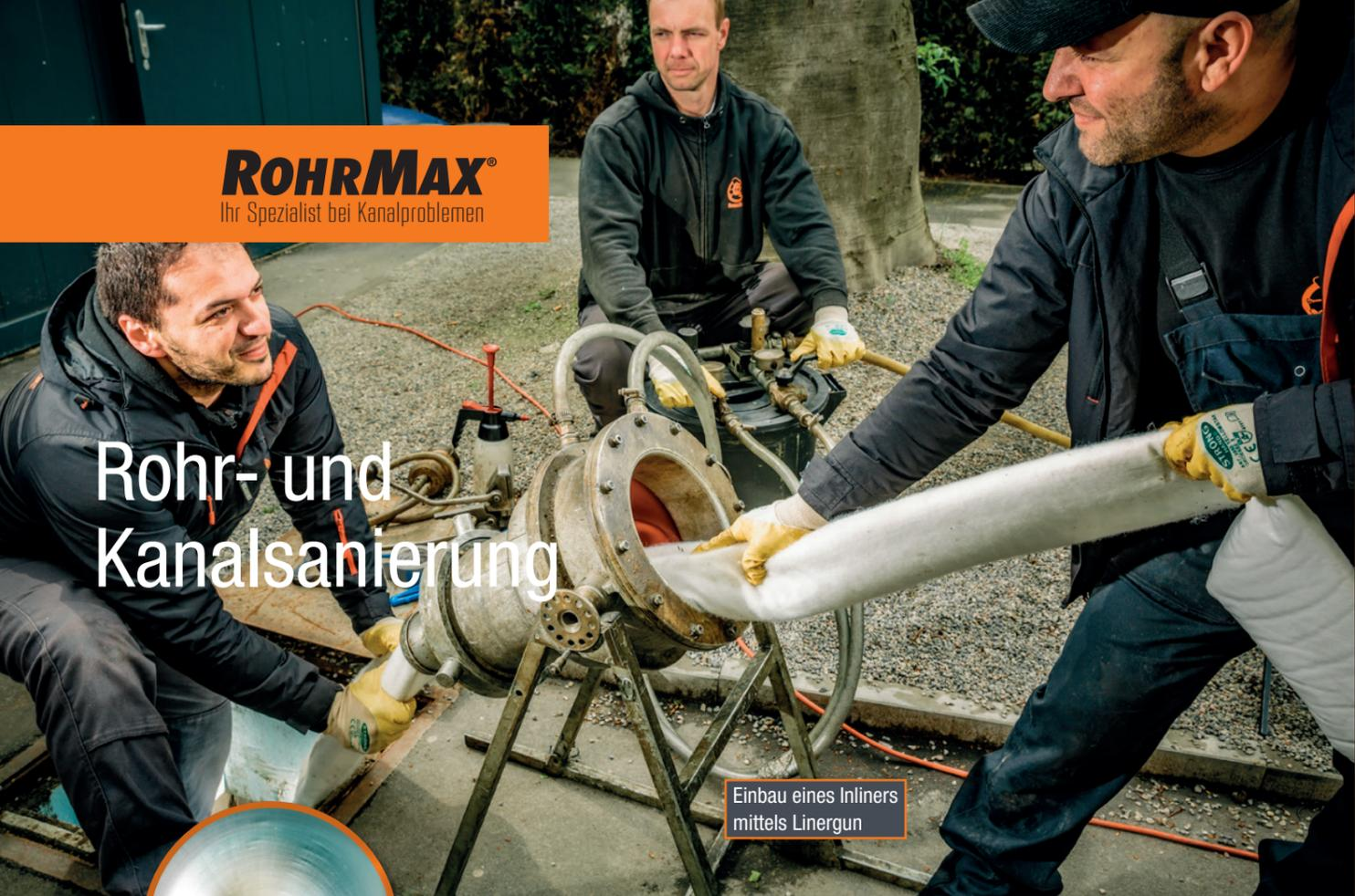
Einbau eines Inliners mittels Linergun
