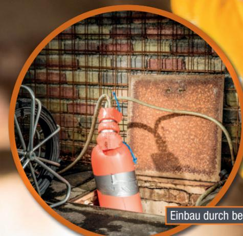
Einbau durch bestehende Putzöffnung
