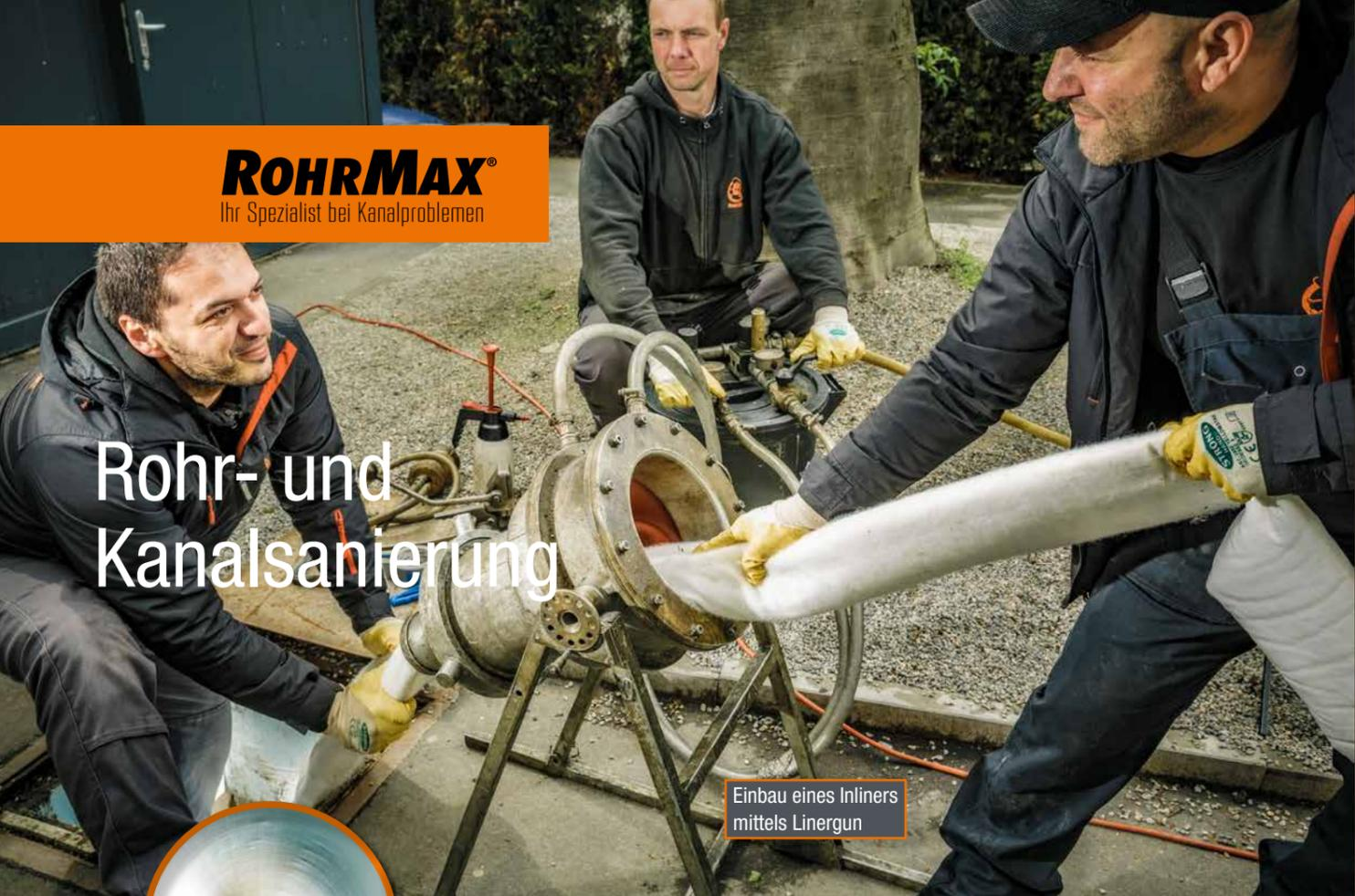
Einbau eines Inliners mittels Linergun
