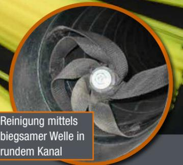
Reinigung mittels biegsamer Welle in rundem Kanal
