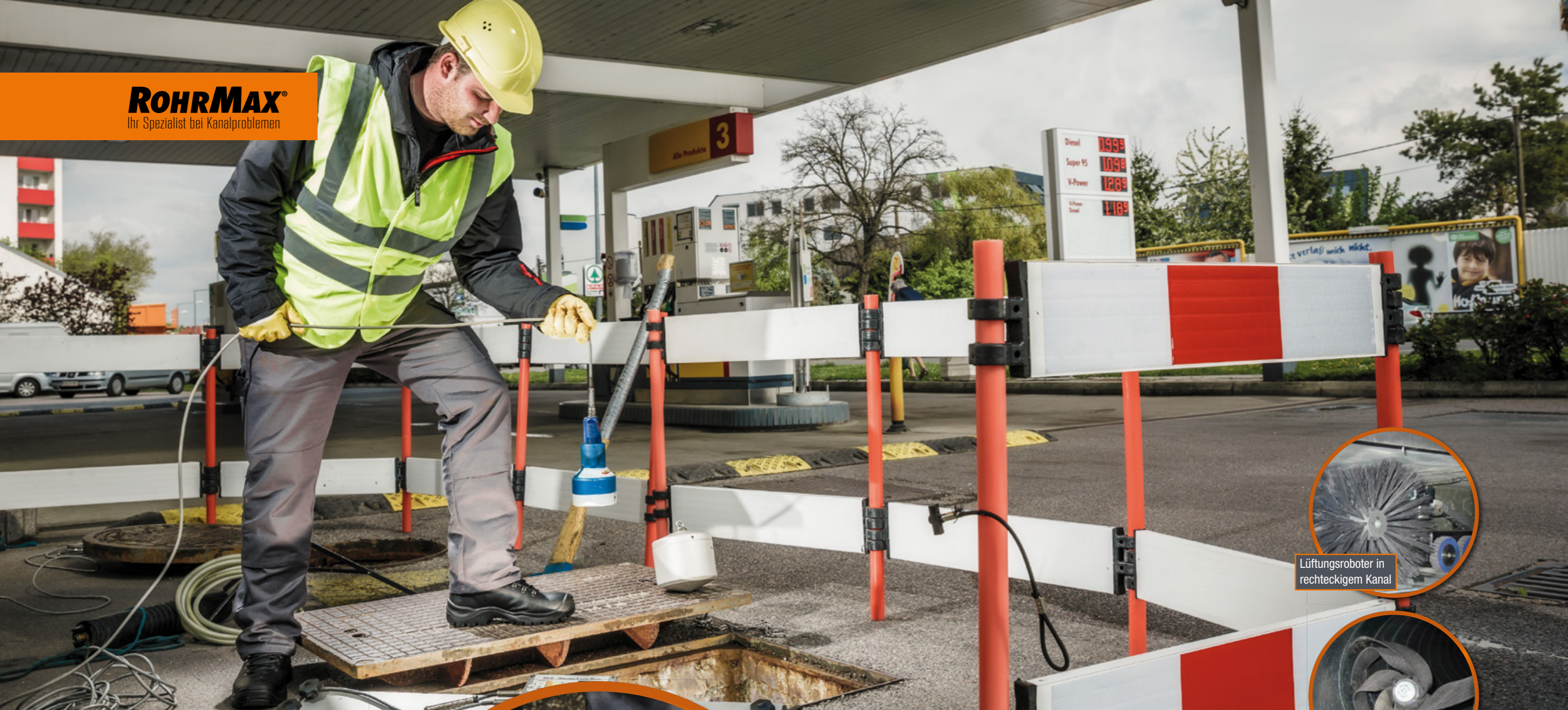
Reinigung mittels biegsamer Welle in rundem Kanal
